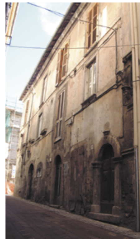
Casa in linea su Via Consolare
