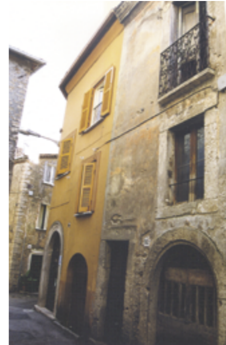
Casa a schiera in Via Antiche Terme
