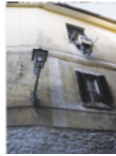
Su una medesima facciata ogni piano è finito in modo differente. In questo caso, indipendentemente dalle differenti proprietà, una finitura omogenea e infissi uguali restituirebbero omogeneità al prospetto annullando in parte anche l'impatto della sopraelevazione.
