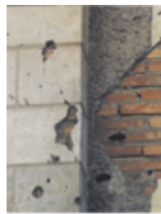
Esempio di intervento mimetico dei primi del secolo: la sopraelevazione in mattoni è stata rivestita con intonaco a finte bugne per inserirla nella costruzione principale
